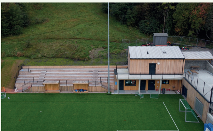
Inngangspartiet fra fotballbanen og ned i anlegget.
